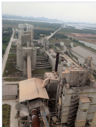
Khảo sát tại nhà máy
