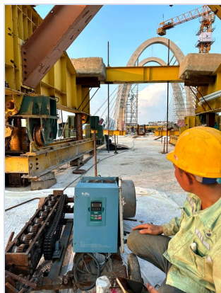
Lắp đặt biến tần tại công trường
