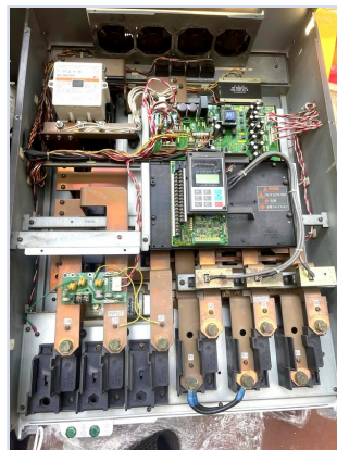
Sửa chữa biến tần
